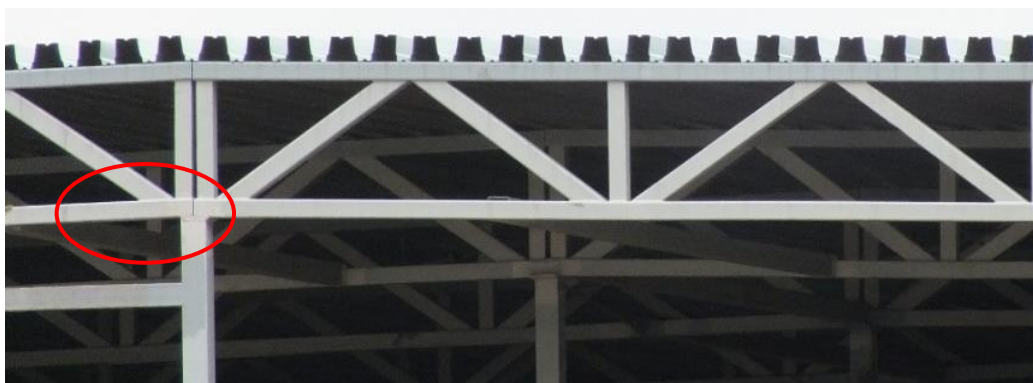
Рисунок 2 – Применение нетипового опорного узла фермы
