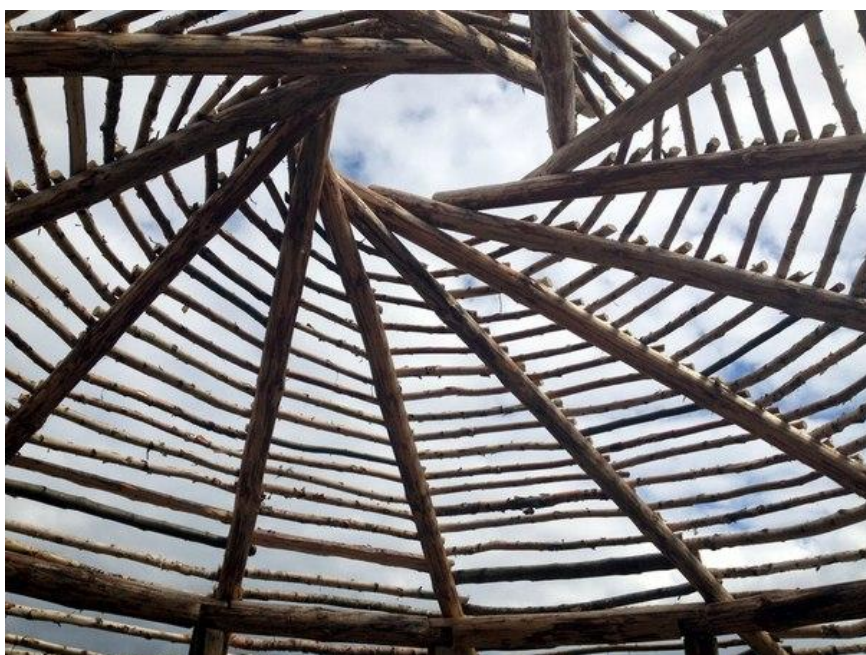
Рисунок 2 – Самоопирающаяся конструкция кровли
